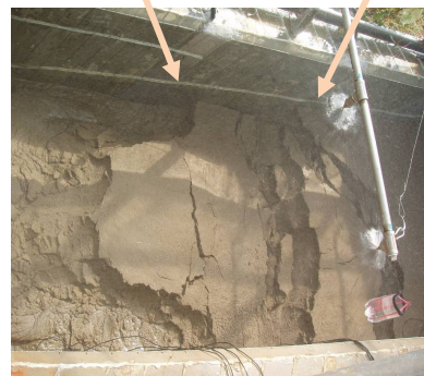
圖 5(d) 大型邊坡試驗在降雨 104 分鐘後，崩塌土體擴展至坡趾後方約 1.7 m 處 (I = 70 mm/hr, t = 104 min)
